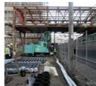
自由通路施工状況(神奈川県)
