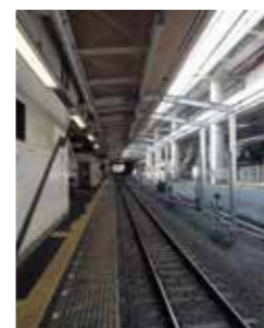
上屋拡張工事(東京都)
